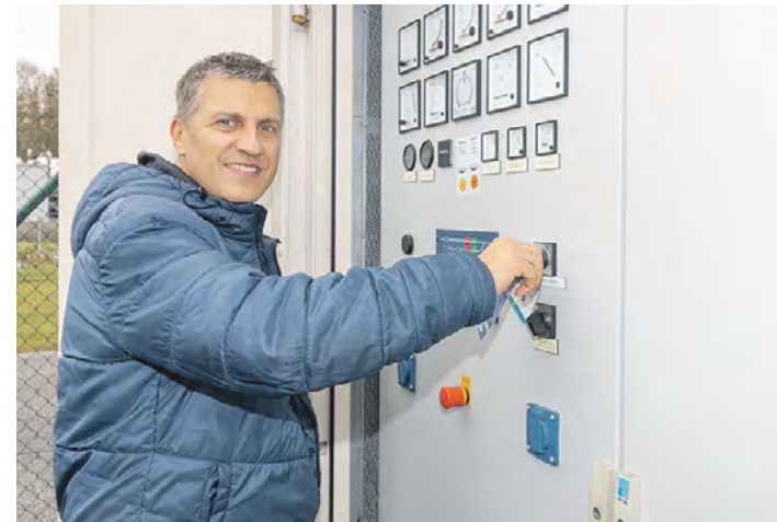
Der DNWAB-Technikchef überlässt nichts dem Zufall. Ist auch an den Schaltschränken alles in Ordnung? Sorgfältig kontrolliert er den Füllstand des Dieseltanks. Fotos (4): SPREE-PR/Petsch
