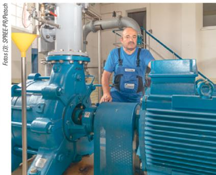
Fünf Pumpen fördern in Eichwalde das Wasser zu Tage. Bei maximaler Leistung sind es 2.100 Kubikmeter pro Stunde, erläutert Maschinist Hendrik Buchholz.
