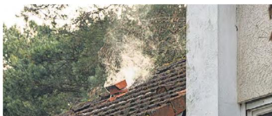
Durch die sogenannte Vernebelung werden Fehlanschlüsse aufgespürt.
