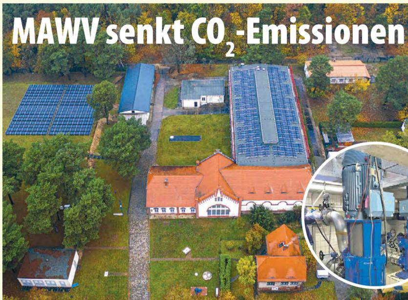
Die PV-Anlage in Eichwalde erzeugt pro Jahr 180 MWh Strom für die Pumpen und die Aufbereitung des Trinkwassers. Durch den Betrieb der Solarpaneele werden jährlich rund 120 t CO<sub>2</sub> eingespart. Eine weitere Anlage plant der MAWV in Schenkendorf.
