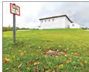
Auf dieser grünen Wiese entsteht der neue Komplex mit Rechen und Sandfang. Im Hintergrund: das alte Rechengebäude.
