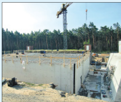
Der Bau des neuen Reinwasserbehälters für das Ludwigsfelder Wasserwerk entstand nach Plänen des Ingenieurbüros pbv potsdam.
