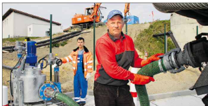
Der KMS sanierte die Zossener Fäkalannahmestation (FAST) von Mai bis Oktober 2011 für 290.000 Euro. Der Vorteil der FAST ist eine genauere Erfassung der eingeleiteten Menge und von deren Inhaltsstoffen. Jährlich werden etwa 130.000 m 3 Fäkalien auf die Kläranlage geleitet. Die Station soll im Januar in Betrieb gehen.
