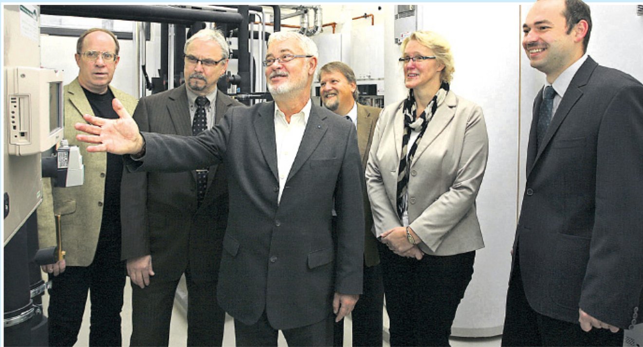
Besuch in der funkelneuen Betriebsstätte Schenkendorf. „Hausherr“ Wolf-Peter Albrecht (MAWV) erklärt die neuartige Heizungs-technik des Gebäudes. Matthias Hein (WAZ Blankenfelde-Mahlow), Rainer Werber (DNWAB), Hans-Reiner Aethner (WARL), Heike Nicolaus (KMS) und Stefan Ladewig (TAZV Luckau) – von links – hören aufmerksam zu. Für die bevorstehenden Feiertage wünschen die DNWAB und ihre Gesellschafter allen Kundinnen und Kunden besinnliche Stunden und ein gesundes neues Jahr!
