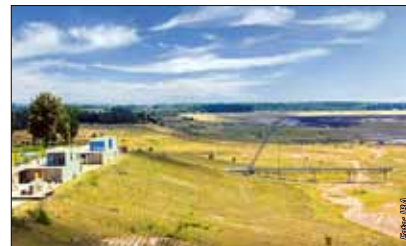
Im Zentrum – 2005 wurde an den IBA-Terrassen in Großräschen ein 63 m langer Steg errichtet, der in den zukünftigen Ilse-See reicht.
