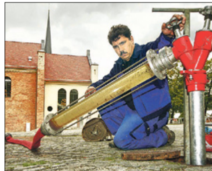
Wasserversorger spülen regelmäßig die Trinkwasserleitungen in ihren Gebieten – unter anderem mit dem Impulspülverfahren. Hierbei „fegt“ ein Luft-Wasser-Gemisch Ablagerungen aus den Rohren.
