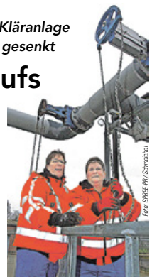
Ortstermin auf der Kläranlage Trebbin: Kerstin Länger-Henschel (links) und Marina Münchow „regeln“ über den Schieber den Zulauf des Schmutzwassers ins Belebungsbecken.
