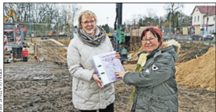
Der KMS Zossen hatte die Maßnahme in Dahlewitz bereits im Oktober 2014 abgeschlossen. KMS-Chefin Heike Nicolaus (l.) und Projekt-Ingenieurin Charlotte Filipov überzeugen sich Anfang Februar 2015 vor Ort vom Vorankommen der Arbeiten an der Bahnunterführung.
