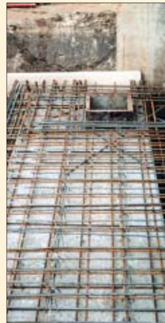
Eine zusätzliche Bewehrung (rechts) sorgt für absolute Dichtheit des Behälters.
