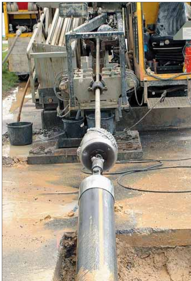
Wunderwerk der Technik – die Horizontalbohrmaschine.
