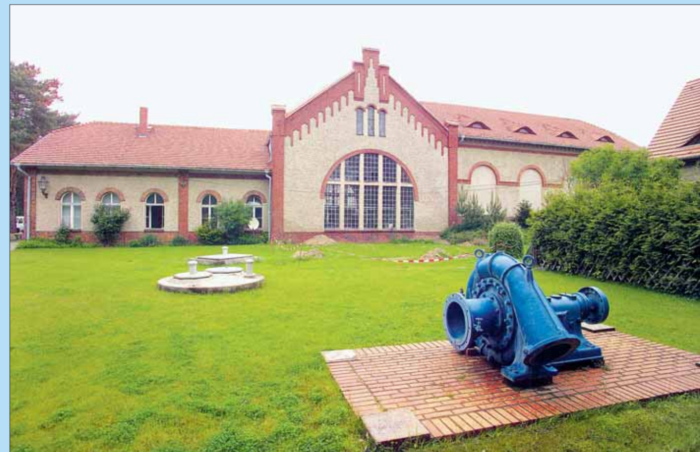
Die Außenhaut des Wasserwerkes erstrahlt bereits wieder im alten Glanz.
