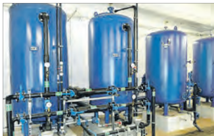
Das im Jahr 1973 gebaute Wasserwerk Borsdorf wurde in den letzten Monaten für 110.000 Euro saniert. Es versorgt rund 500 Einwohner.
