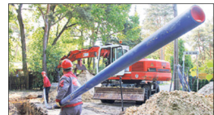
Die Seebadsiedlung am Motzener See im Norden des Ortes erhält derzeit einen zentralen Trinkwasseranschluss. Leitungen auf einer Länge von fast 4.700 Meter kommen dabei in die Erde.
