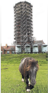
Der Wasserturm in Dahme wird seit Anfang Mai saniert.
