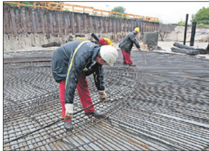
Die Eisenstreben für das neue Belebungsbecken werden verlegt.
