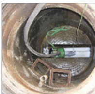
Temperatursonden für den Innener der Schmutzwasserkanals in Trebbin werden montiert.
