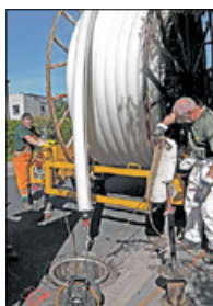
Das neue Rohr wird von den Fachleuten „eingefädelt“.
