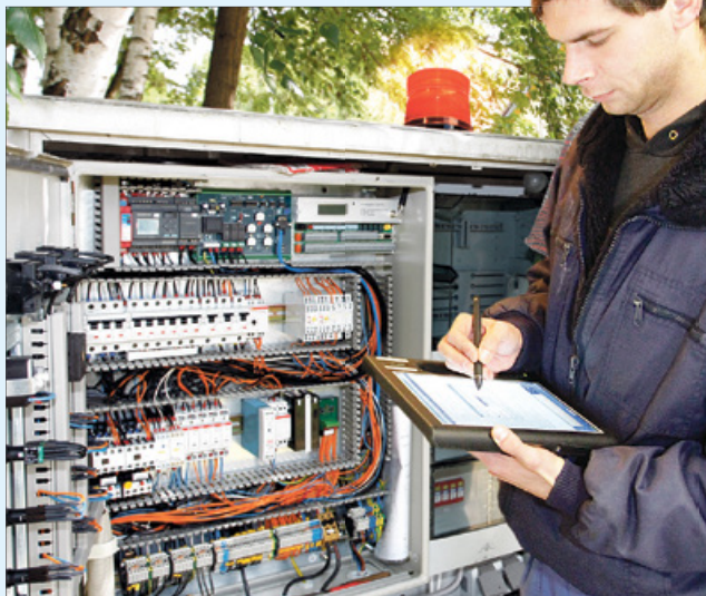
▲ DNWAB-Mitarbeiter Olaf Thoms kontrolliert die „Ablaufwerte“ eines Schmutzwasserpumpwerkes.
