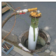
Aufheizphase des Inliners – Wärmeaufschlag und Druckluft bewirken eine Rückverformung.
