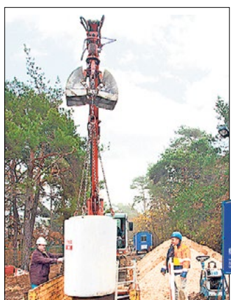
Die ESO-BAU GmbH & Co. KG war für den MAWV bereits 2011 bei der Sanierung der Kanäle in Zernsdorf tätig.
