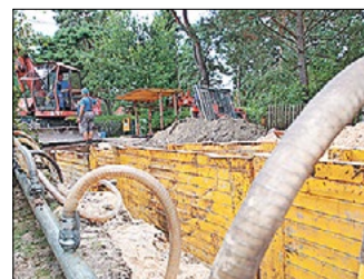
Die Schläuche verraten es: Der hohe Grundwasserstand muss teilweise abgesenkt werden.
