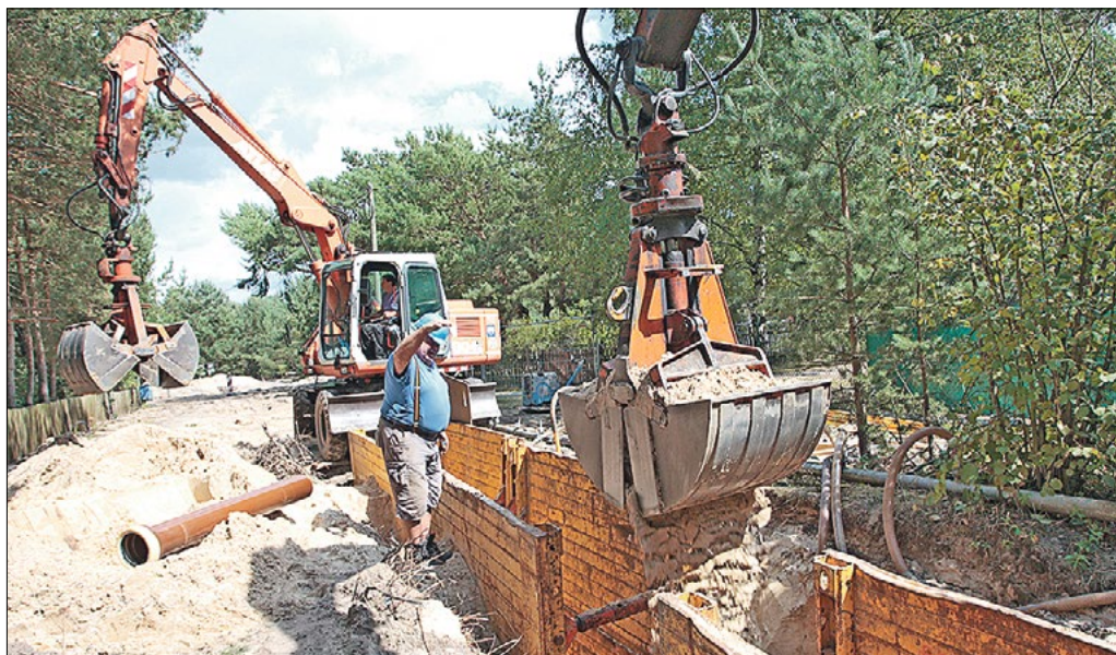
„Zwei vor eins“ heißt es in der Hintersiedlung in Bestensee. Denn zuerst haben Ende Juni die Bauarbeiten für Los 2 begonnen. Mittlerweile schreiten auch die Arbeiten beim Los 1 zügig voran.
