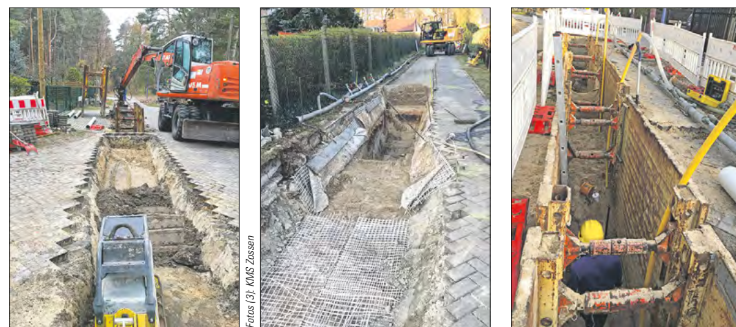
Der KMS Zossen investiert 2,9 Mio. Euro in die Schmutzwasserschließung der Seebadsiedlung Motzen.
