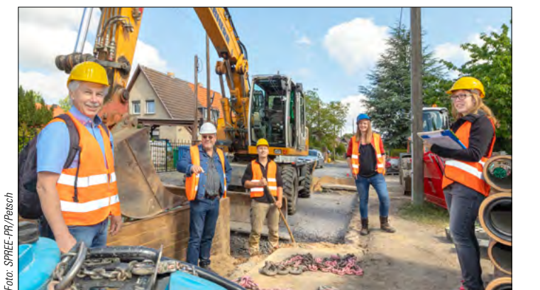
Die Fünf von der Baustelle Waldstraße: Dr.-Ing. Thomas Stammnitz (Ludwigsfelde), Bauleiter Olaf Fibian (Ingenieurbüro), LauBau-Polier Marcus Thamm, Kathrin Herbst (DNWAB) und Annica Meier vom Ingenieurbüro Drömer (v.l.).
